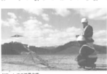
ドローンでの測量作業
